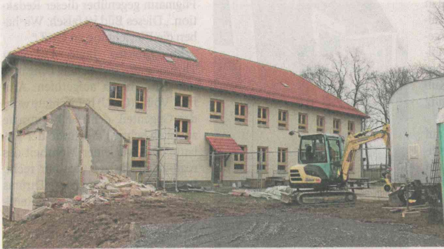
Der alte Schuppen am Raniser Kindergarten „Burgspatzen“ wird abgerissen, um Platz für den Anbau zu schaffen.
