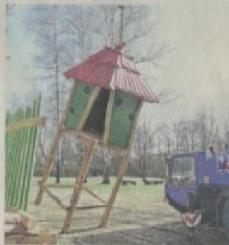
Der Spielturn wird mit einem Kran an Ort und Stelle gehievt. FOTO: DIRK BÖHME
