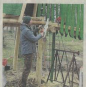
Spielplatzgestalter Jörg Böhme erledigt die Feinarbeiten am neuen Spielgerät.
